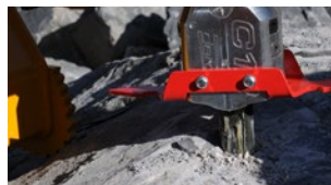
Anschließend dringt der hydraulische Keil mit einem Druck von etwa 100 bar...
